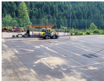
Stand Bauarbeiten am 20.06.2023
